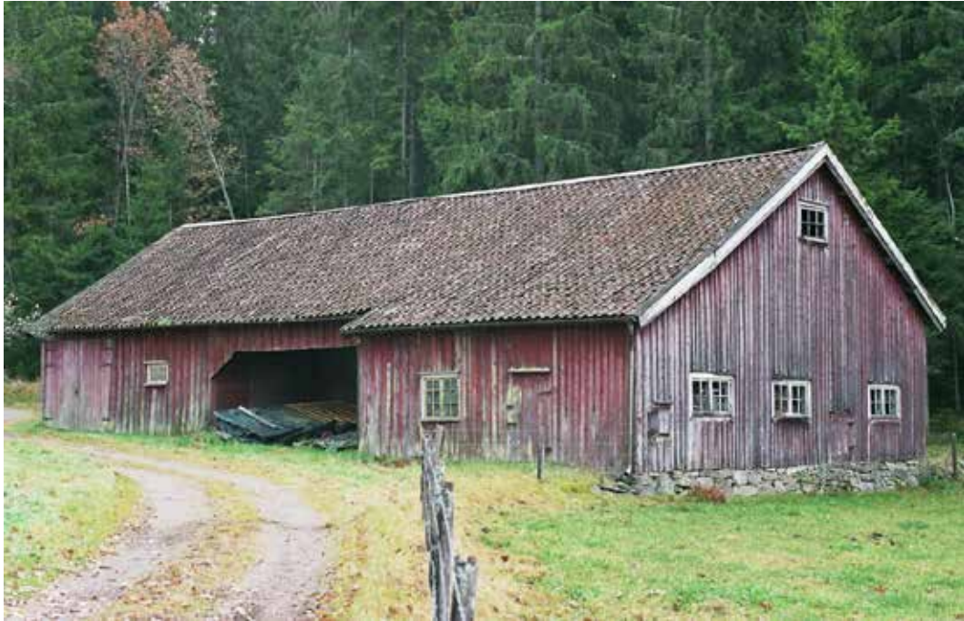
Skunke, en infälld logport, har använts av hantverkare som en skyddad plats för förvaring av materialet (kvistar och grenar) och där man kunde arbeta under tak i dagsljus. Foto: Erik Andersson
